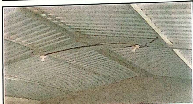
Foto 4: Finalizacion de instalación electrico dentro de las aulas.
