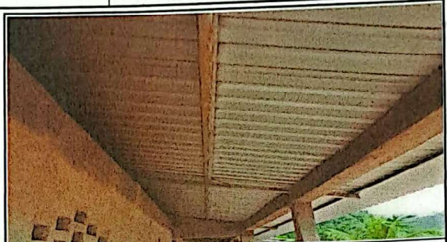
Foto 2: Finalización de colocación de tubos y costaneras de metal para darle mas estabilidad a las laminas y evitar las filtraciones de agua.
